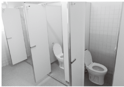
小学校トイレの洋式化を進めます
