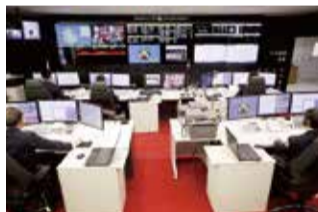
消防緊急情報システム(消防指令センター)
