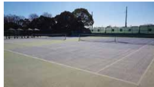
改修した出羽公園庭球場
