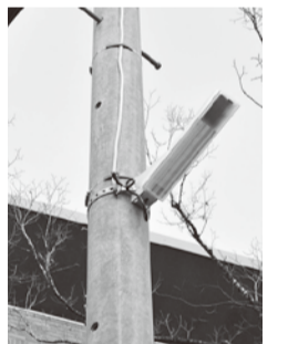
生活道路に設置されているLED灯
