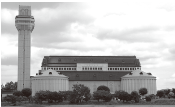
第一工場全景
