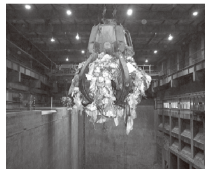
焼却炉にごみを投入する巨大クレーン
