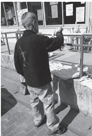
活動の一例(学童保育室の手すりの塗装)
