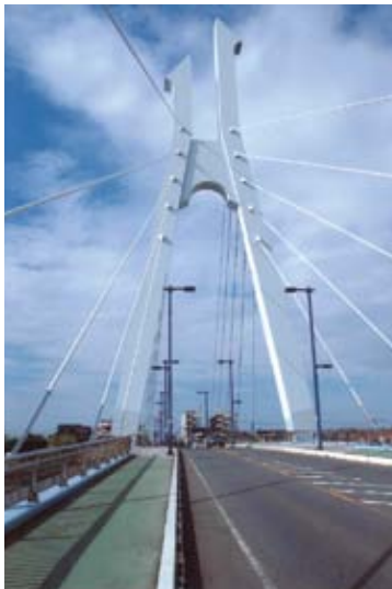
◀元荒川と葛西用水に架かるしらこぼと橋が開通〔平成6年〕
