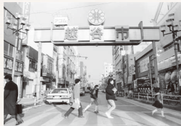
▼越谷駅前通りの電線埋設工事が行われる(昭和60年代)
