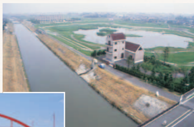
▲大吉調節池が完成(平成3年)
