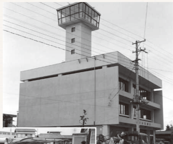
▲消防署庁舎(昭和42年)
