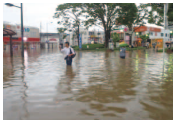
▲大雨で冠水したせんげん台駅東口
