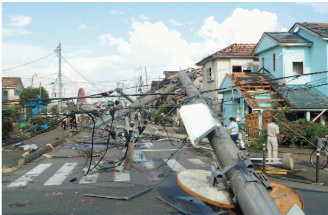
▲竜巻で大きな被害を受けた大杉橋付近の住宅地
