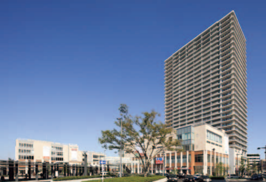
▲越谷ツインシティがオープン(平成24年)
