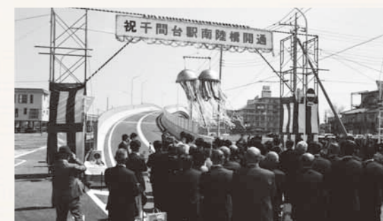
▲千間台駅南陸橋が開通(昭和57年)
