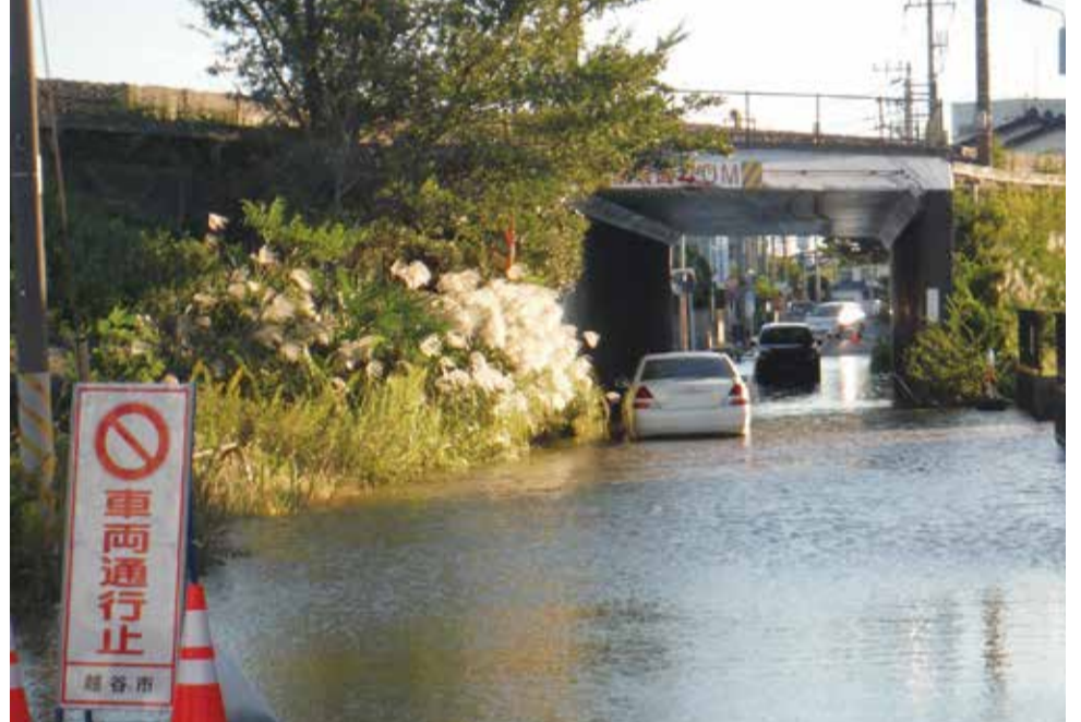
10月13日、出羽地区内の様子(市職員撮影)
