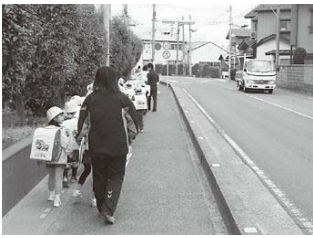
通学路の歩道を整備します
