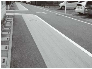
通学路の路肩をカラー舗装します
