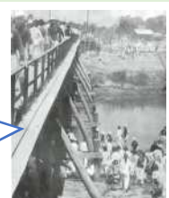
不動橋の下から土を運んで、校庭に土盛り作業
