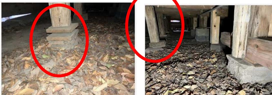
【写真左】 束と礎石との間が開いている（礎石の沈下）
