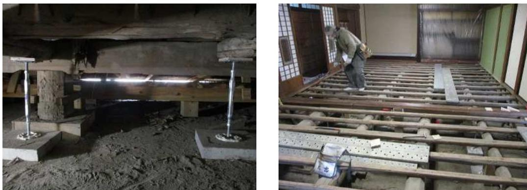
【写真左】 鋼製束を新設し、既存束への負荷を分散した
