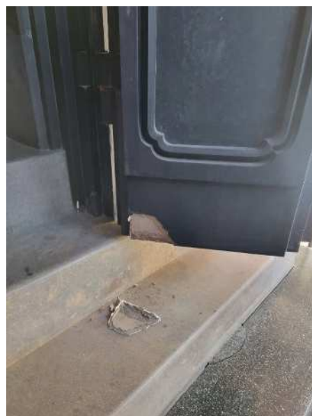
<未着工> No.8土蔵観音開き扉破損箇所
