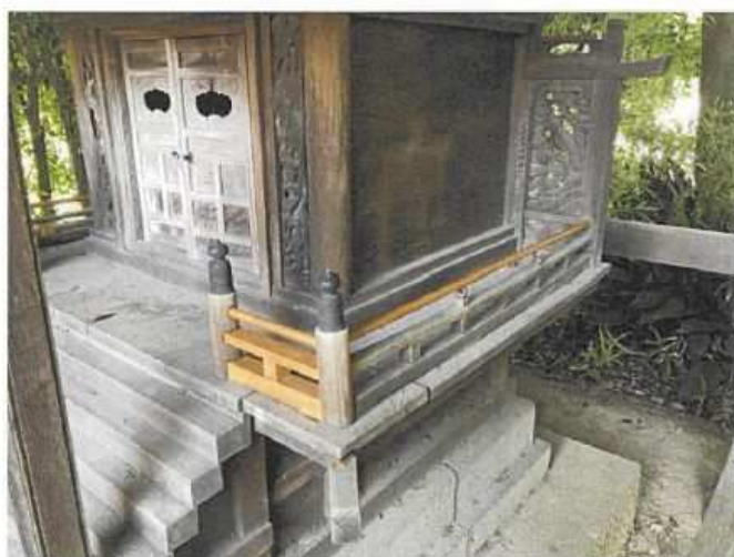
<施工済み> No.1御嶽社縁側の高欄修繕
