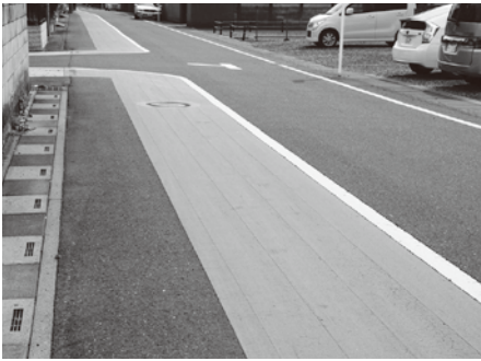
通学路の路肩をカラー舗装します
