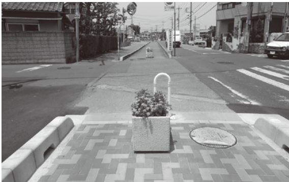
整備が進む須賀川通り（手前が整備された歩道、奥が整備予定の歩道）
