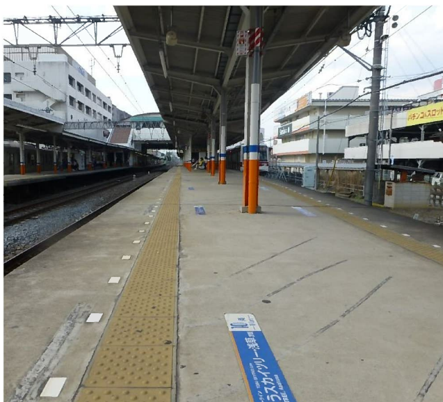
写真7：施工前の状況（せんげん台駅上りホーム）
