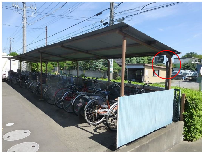
写真5：越谷南体育館(看板設置状況)
