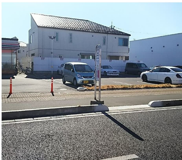
写真2：②工事後の状況 (第九公園入口：大袋駅西口方面行き)
