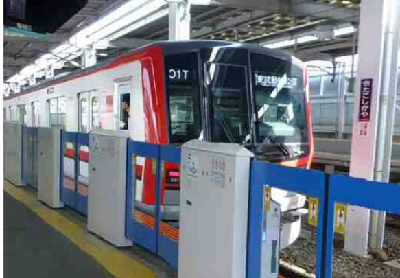
写真6：ホームドア完成イメージ (北越谷駅下りホーム)
