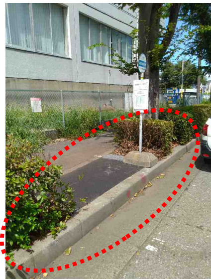
写真4：工事後のバス停の状況
