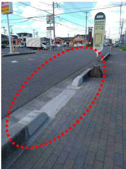
写真3：工事後のバス停の状況
