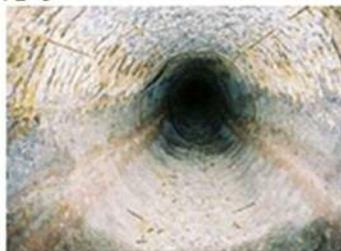
硫化水素による管路の腐食
