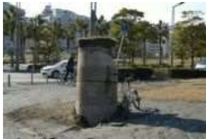
液状化によるマンホール浮上
