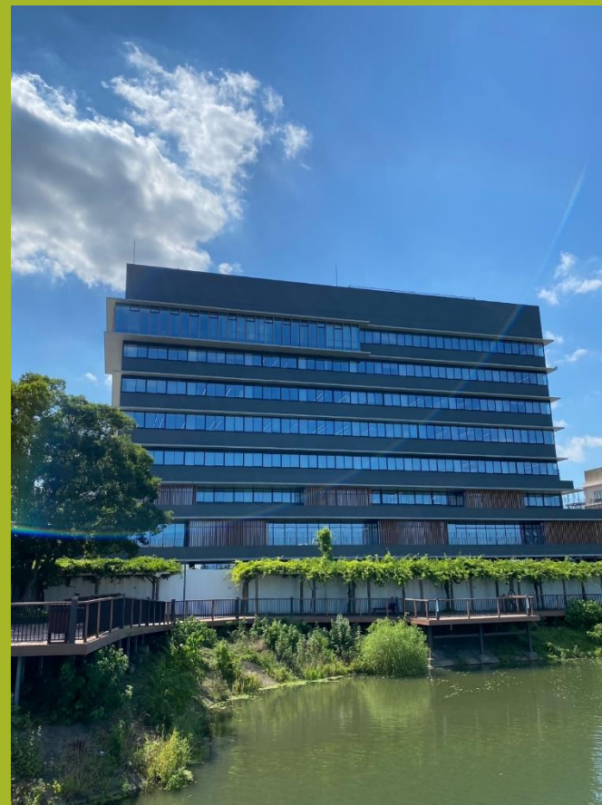
越谷市役所本庁舎 (元荒川、葛西用水側から)
