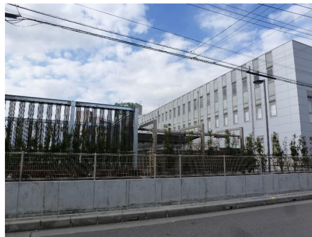
敷地及び設備外周の緑化
