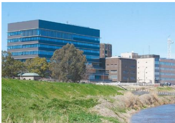
R3-28 越谷市役所と元荒川
