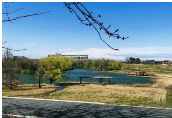
R3-6 大吉調節池
