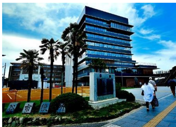
R3-36 越谷市役所本庁舎
