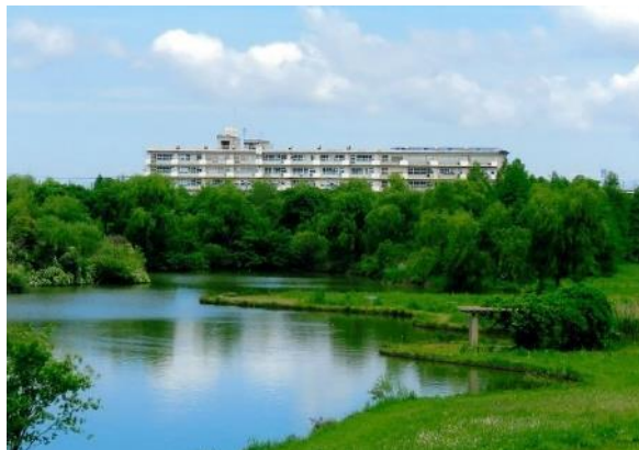
R3-52 大吉調節池
