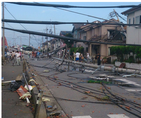
図1-1. 竜巻災害時における越谷市内の電柱倒壊事例
