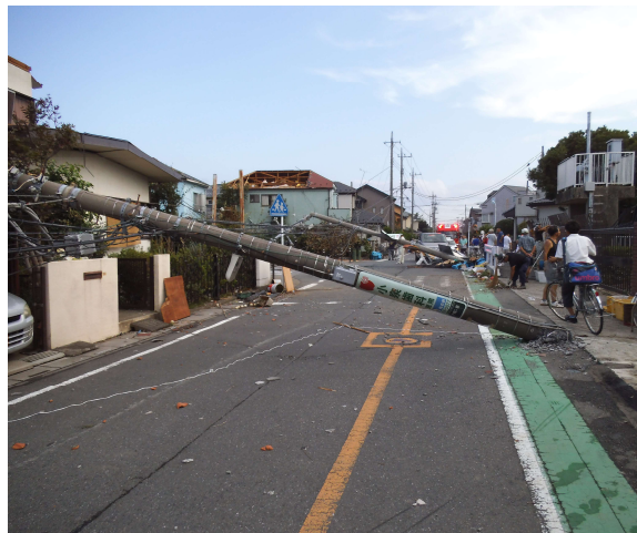
図1-1. 竜巻災害時における越谷市内の電柱倒壊事例
