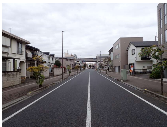
都市計画道路 新越谷駅北通り線
