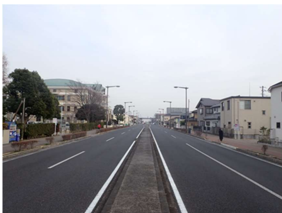
都市計画道路 大袋駅西口線 (市施工の電線共同溝方式)
